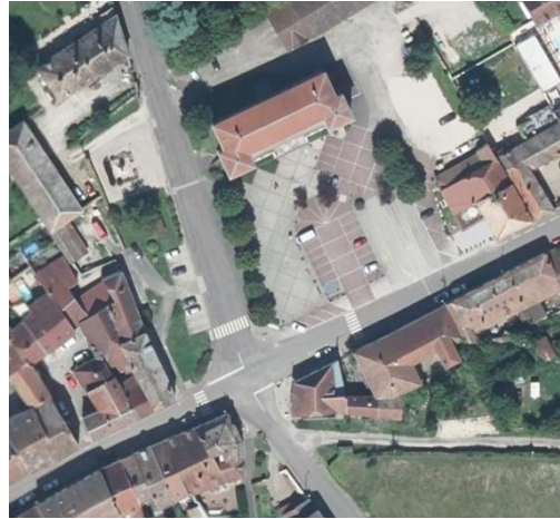
Place de l'hôtel de ville à Gy Source : Géoportail - 2020
