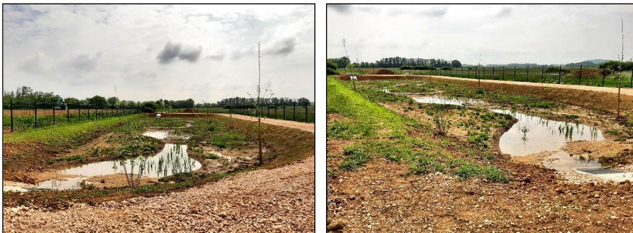
Figure 15 : Exemple de bassin de rétention végétalisé
